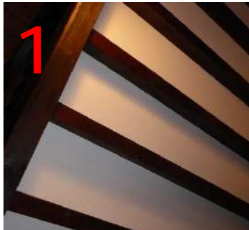
Plafond sous rampant
